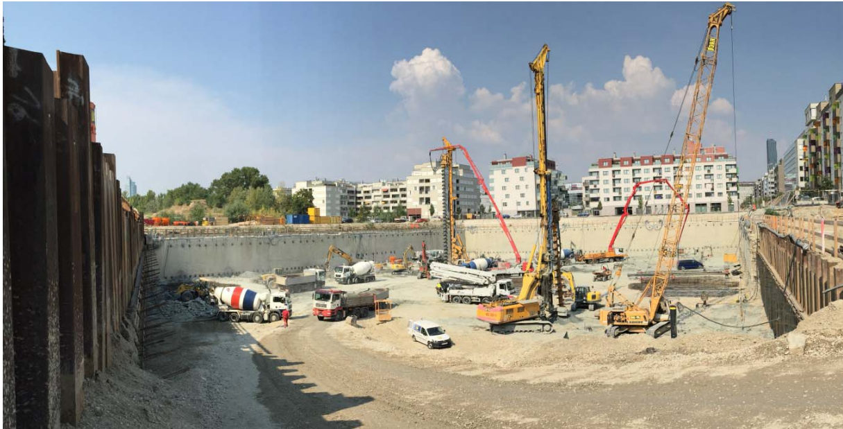
Abb. 2 - Bohrpfahlarbeiten Baufeld 8 im Schutz der Schlitz- und Spundwandumschließung
