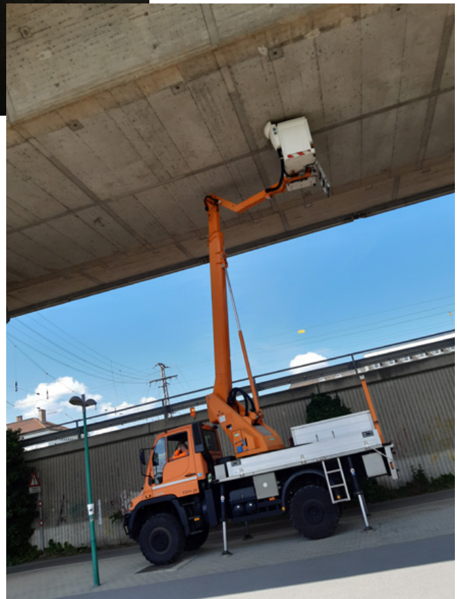
Abb. 4-5: Fotos aus Begleitung bei Brückenprüfung
